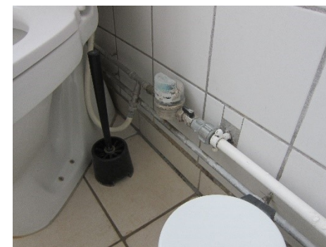
Installation fornyet delvist med rustfrit stål
