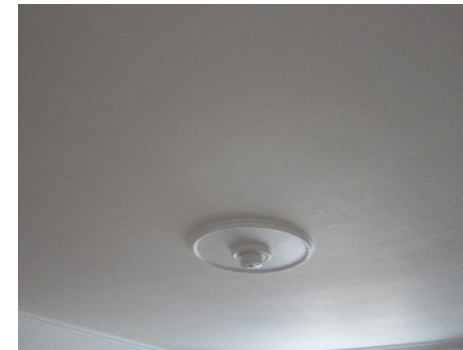
Loft uden revner
