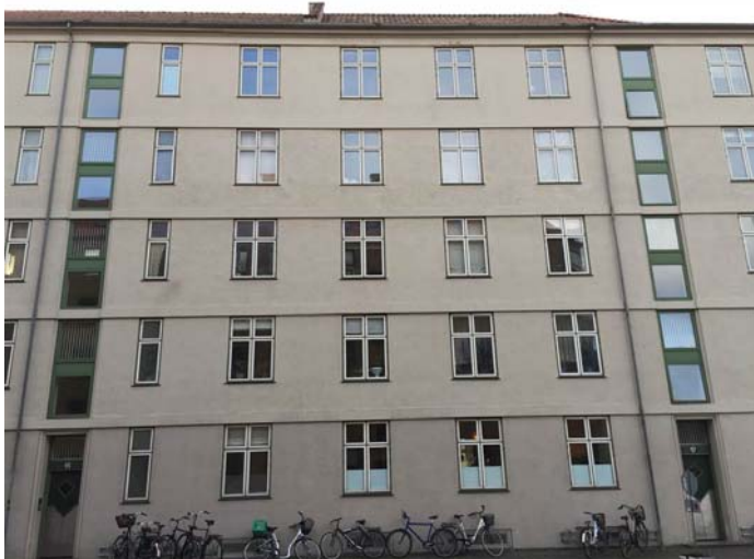
Facade strukturen fremstår velholdt.
